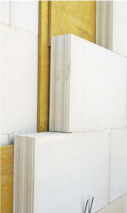
**Bild 47** Dicht gestoßene Mineralfaserplatten Typ WTH vermeiden Schallbrücken.
