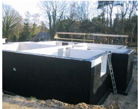
**Bild 10** Kellerwand-Außenseite mit PMBC-Abdichtung
