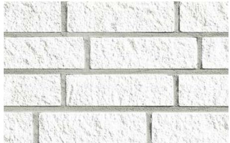
**Bild 11** Sichtmauerwerk aus bruchrauen KS-Verblendern, Format NF
