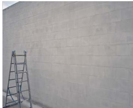
**Bild 8** Geschlämmtes KS-Mauerwerk mit KS-Plansteinen
