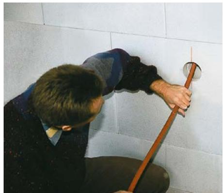
**Bild 6** Einziehen eines Leerrohres
