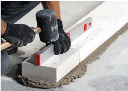
Bild 2 Kontrolle der Ebenheit in Wandlängsrichtung
