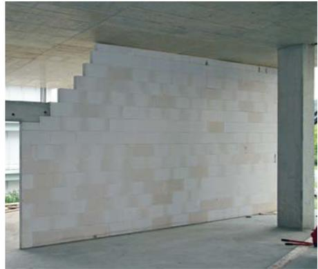
**Bild 31** Nicht tragende Innenwand aus Kalksandstein-Bauplatten mit oberer Halterung
