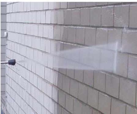
Bild 36 Reinigung mit Dampfstrahlgerät
