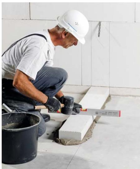
Bild 9 Kimmsteine in Querrichtung ausrichten
