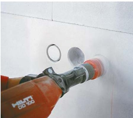
**Bild 5** Fräsen von Öffnungen für Schalterdosen
