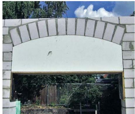
Bild 23 Ausführung eines Flachbogens auf einer Holzschablone
