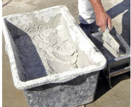
**Bild 5** Der Dünnbettmörtel wird in den Mörtelschlitten eingefüllt.
