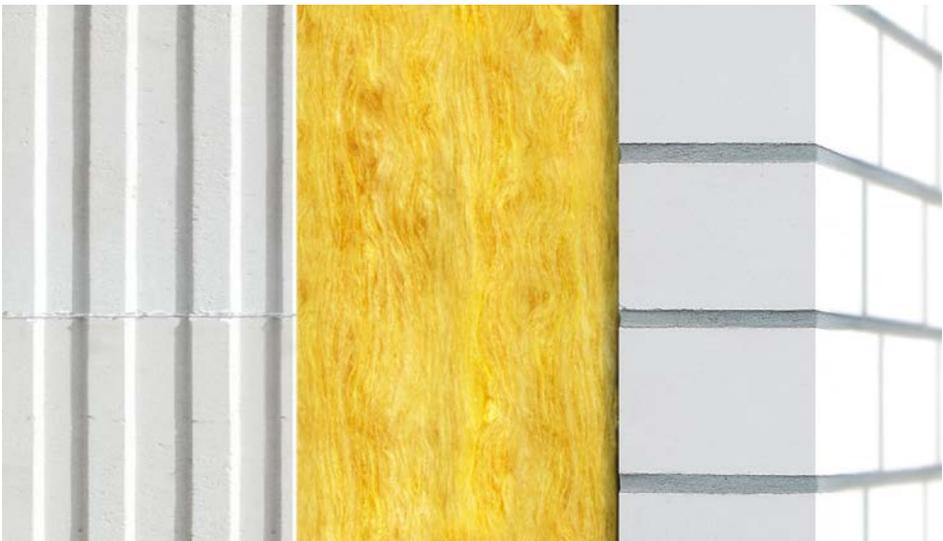
Bild 2 Zweischaliger Wandaufbau mit Hintermauerung, Dämmung und Verblendung
