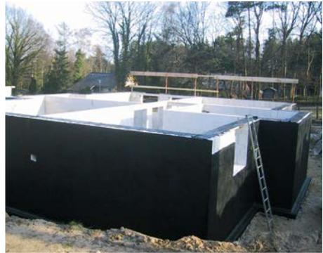
**Bild 3** Kellerwand-Außenseite mit PMBC-Abdichtung
