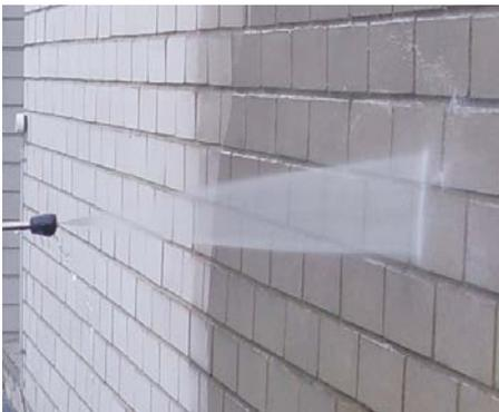
Bild 29 Reinigen mit Dampfstrahlgerät
