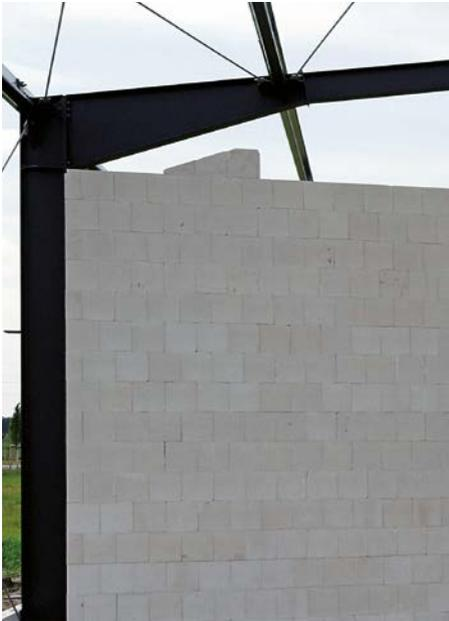
**Bild 24** Kalksandstein-Mauerwerk als Ausfachung einer Stahlkonstruktion
