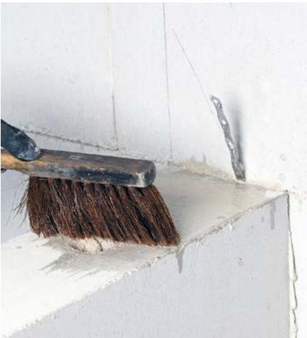
**Bild 6** Bei hohen Außentemperaturen sind die Steine vorzunässen.
