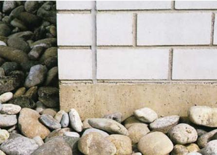
Bild 47 Dehnungsfuge an einer Gebäudeecke mit spritzbarem Dichtstoff
