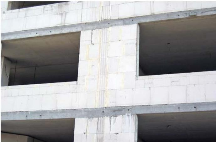
Bild 42 Durch die Außenwand durchgeführte Wohnungstrennwand
