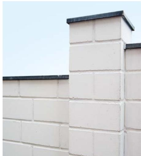
Bild 27 Gemauerter Pfeiler aus KS-Verblendern
