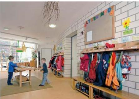
**Bild 3** Innensichtmauerwerk aus KS-Verblendern
