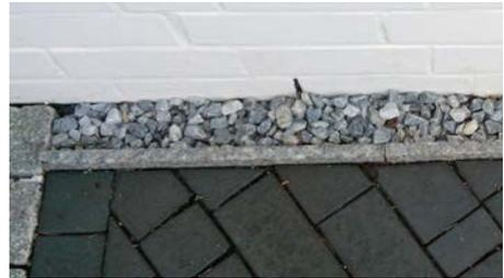
**Bild 43** Beispiel für eine Fußpunktausbildung mit Kiesrandstreifen
