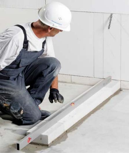
**Bild 10** Kimmsteine in Längsrichtung ausrichten
