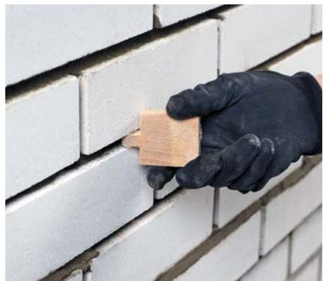
**Bild 29** Auskratzen der Fugen mit einem Holzbrettchen
